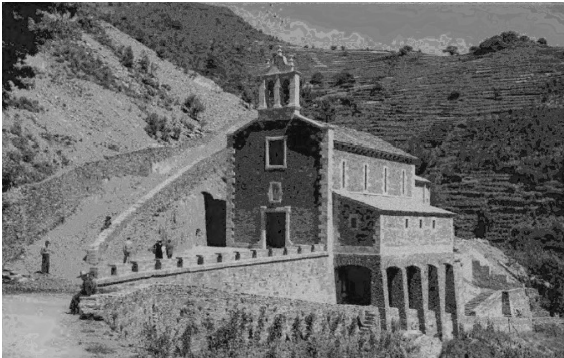
Vista xeral na nova ubicación o remate da obra.
